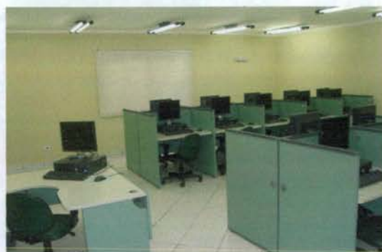
Supervisão/Central de Processamento de Dados
